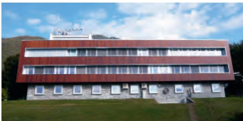
Die Wetterzentrale in Locarno-Monti wurde nach Minergie-Standards renoviert.
