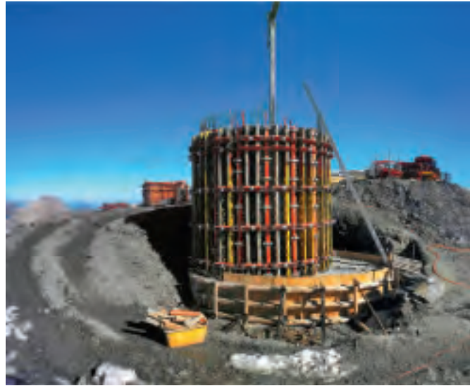
Auf der Plaine Morte kehrt Leben ein: Im Herbst 2012 starten im Walliser Hochgebirge die Bauarbeiten für das vierte Schweizer Wetterradar.
