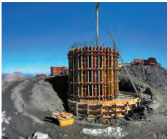
Sulla Pointe de la Plaine Morte c'è vita: nell'autunno 2012 sono iniziati i lavori in quota per la costruzione del quarto radar meteorologico svizzero.
