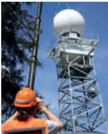
Grande precisione con la gru è richiesta durante i lavori di rinnovo del radar sull'Albis nel maggio 2012.
